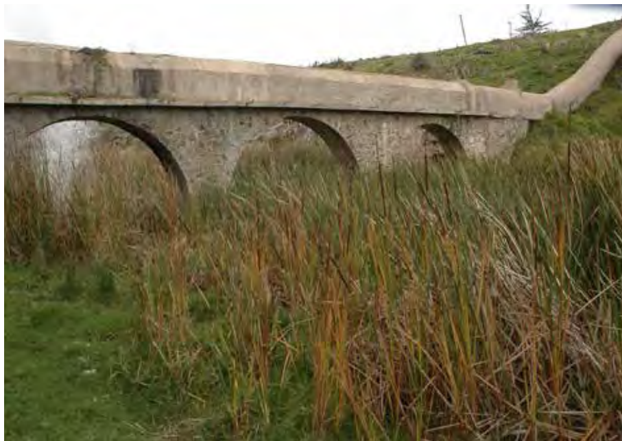
Canal Bellavista (El sifón) (La Cantera) / Bellavista Canal (El Sifón, La Cantera)
