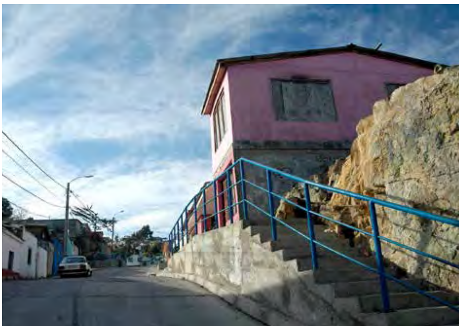
Casa Rosada, sector Parte Alta, Calle Bellavista / Pink house in Bellavista Street (Parte Alta)
