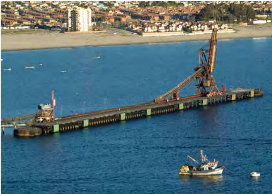
Muelle mecanizado CMP, (Guayacán) / CMP's mechanical pier (Guayacán)
