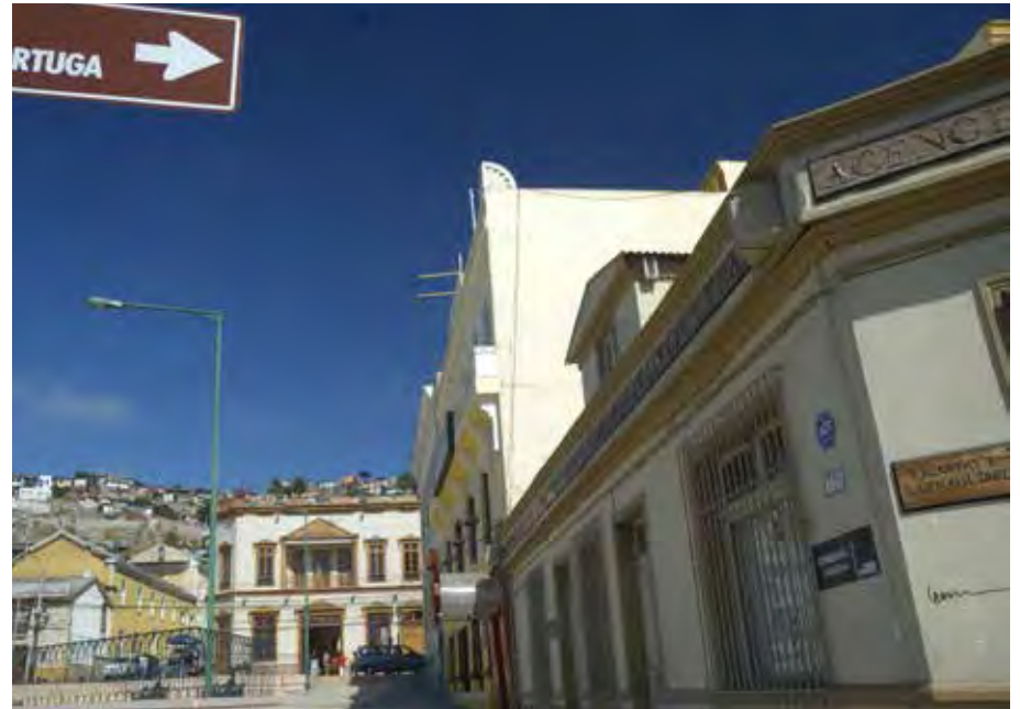
Edificio Agencia de Aduana (Puerto) / Customs Office Building (Port)
